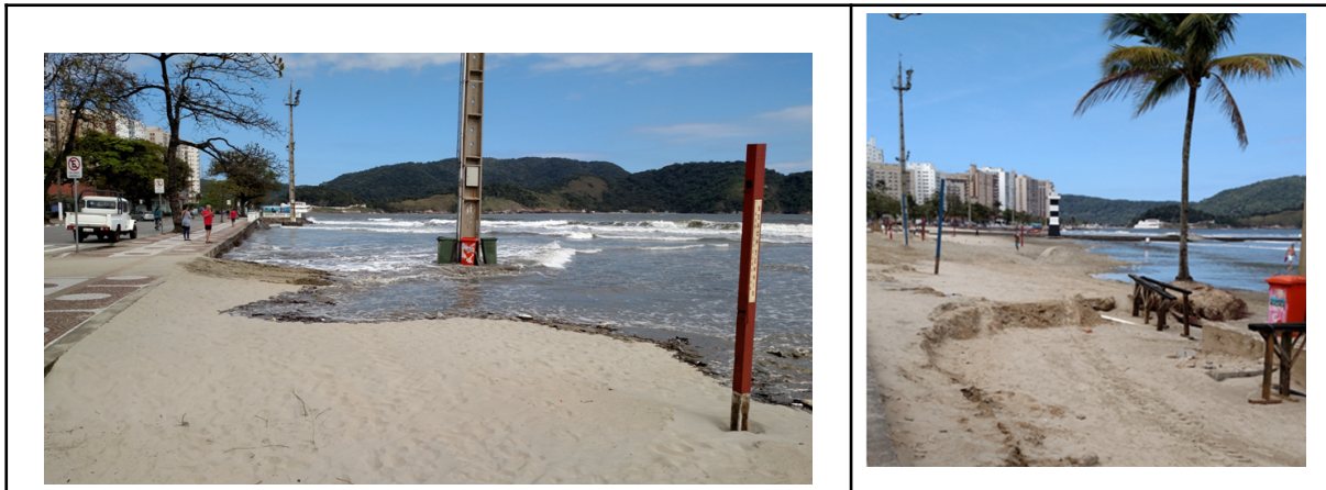
Figura 1.2.7.1. Perfil praiado erodido após evento de ressaca de setembro de 2016. Fonte: Projeto Piloto para Monitoramento e Mitigação dos Efeitos Erosivos da Ponta Da Praia (2018) 12 .
