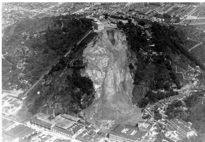
Figura 3.1.4. Escorregamento do Monte Serrat, em 10 de março de 1928 Fonte: IPT 23 .
