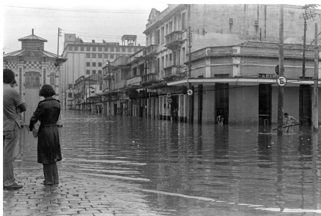
Figura 3.1.6. Confluência das ruas João Otávio e General Câmara, tendo em destaque uma das estações elevatórias e o restaurante Chave de Ouro, nos dias seguintes às chuvas, em março de 1978. Fonte: Site Novo Milênio 26 .
