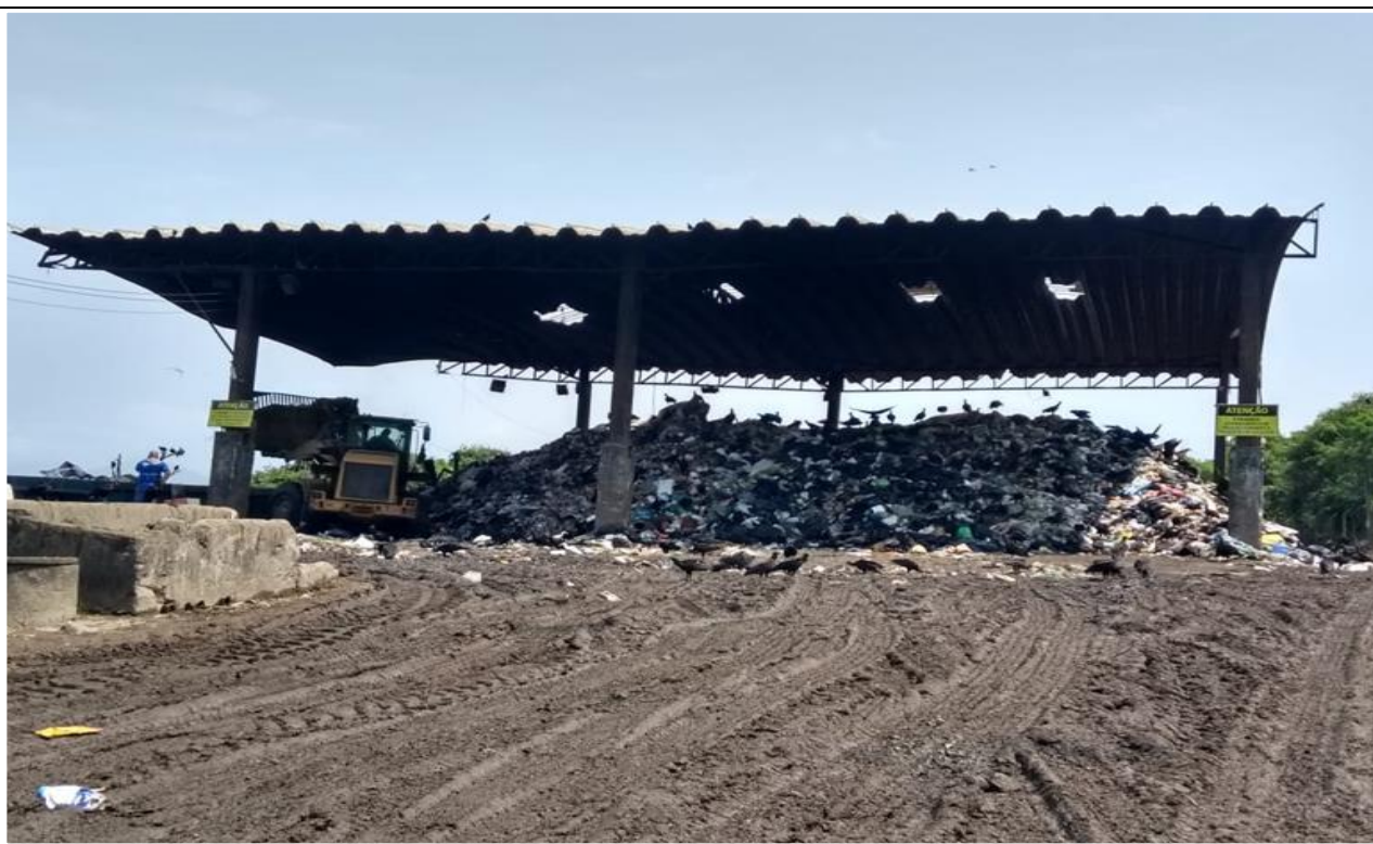
Foto 6 – Transbordo de resíduos sólidos urbanos – Entrada da carreta à direita e rampa de carga à esquerda – Bairro Alemoa.
