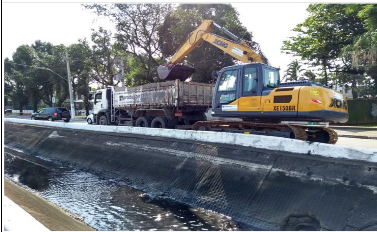
Foto 16 – Limpeza mecanizada de canal - Av. Hugo Maia - Zona Noroeste. Coordenadas UTM: 359303 E 7351635 N.
