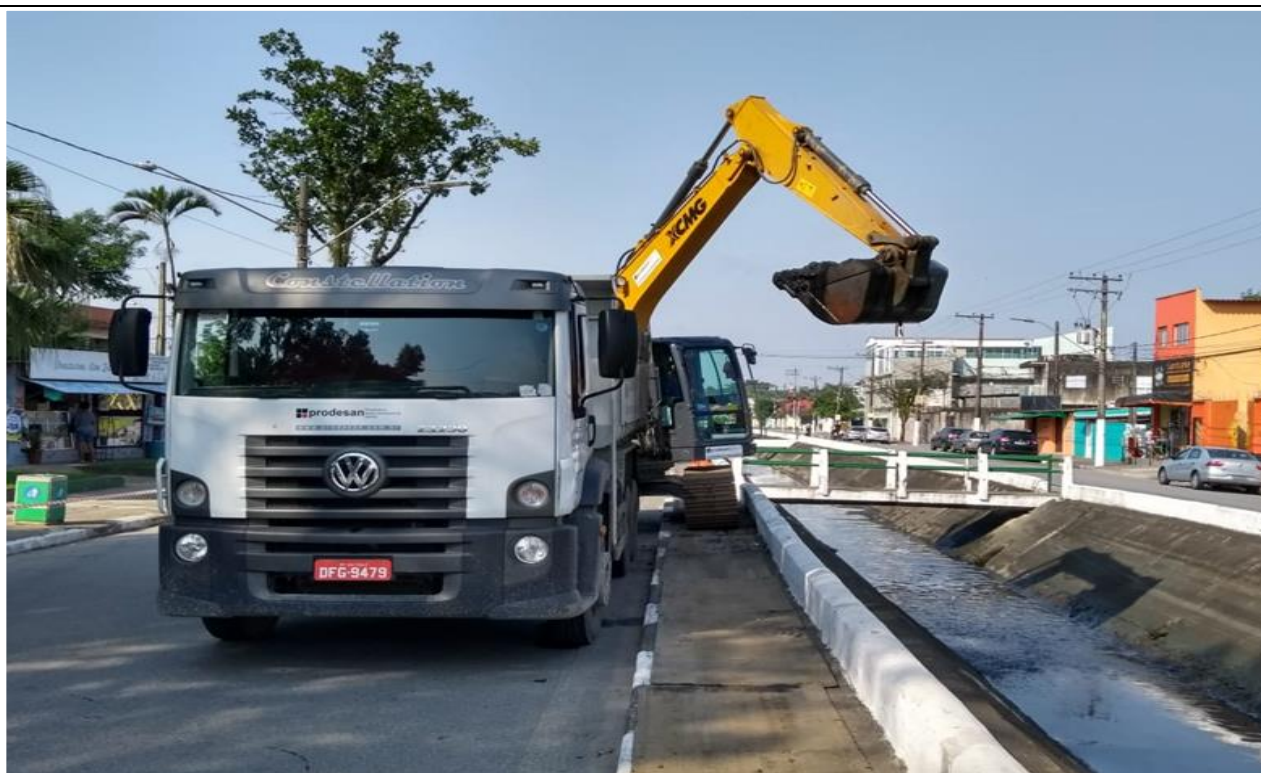
Foto 16 – Limpeza mecanizada de canal - Av. Hugo Maia - Zona Noroeste. Coordenadas UTM: 359303 E 7351635 N.
