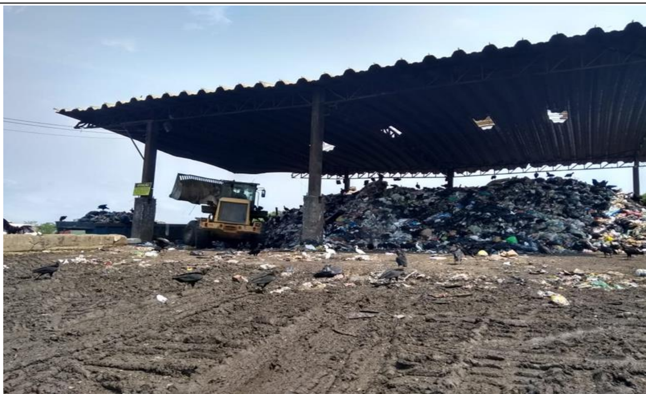
Foto 10 – Transbordo de resíduos sólidos urbanos – Entrada da carreta à direita e rampa de carga à esquerda – Bairro Alemoa. Coordenadas UTM: 357888 E; 7353597 N.
