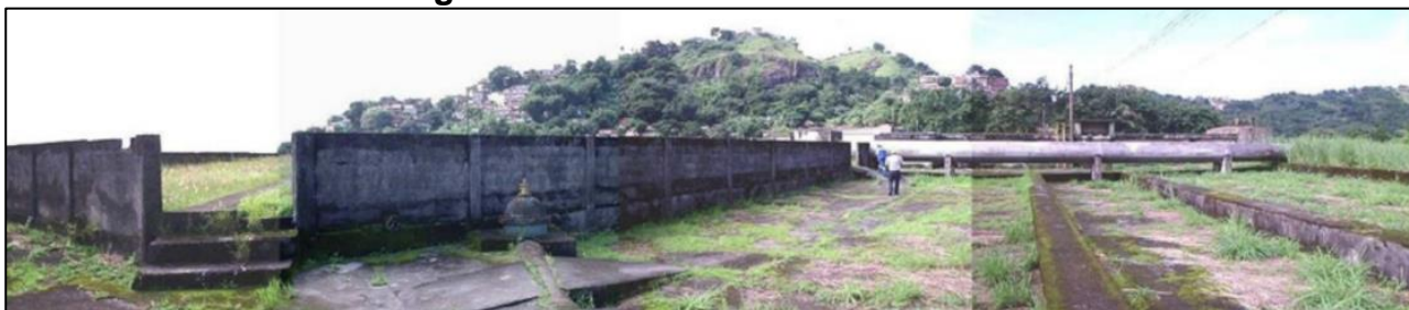
Figura 22 – Reservatório Saboó Alto.
