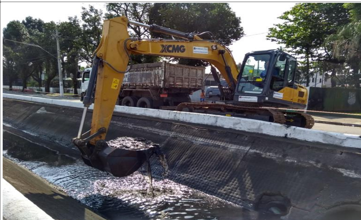
Foto 14 – Limpeza mecanizada de canal - Av. Hugo Maia - Zona Noroeste. Coordenadas UTM: 359303 E 7351635 N.
