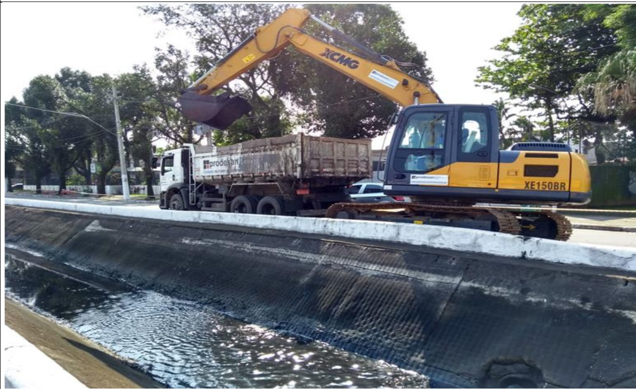
Foto 14 – Limpeza mecanizada de canal - Av. Hugo Maia - Zona Noroeste. Coordenadas UTM: 359303 E 7351635 N.
