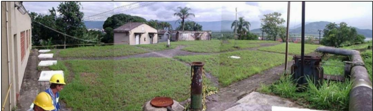
Figura 21 – Reservatório Saboó Baixo.
